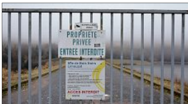
ANCIENNE MINE. Suite à l'exploitation, des déchets radioactifs ont été placés au fond d'un lac artificiel dans l'ancien lit de la rivière La Besbre, et les autres dans les galeries minières. A.M.
