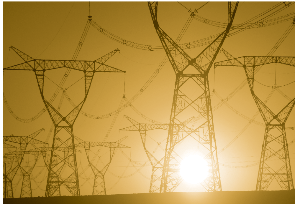
Elevage de pylônes électriques profitant du coucher de soleil. Xinjiang, Chine.
